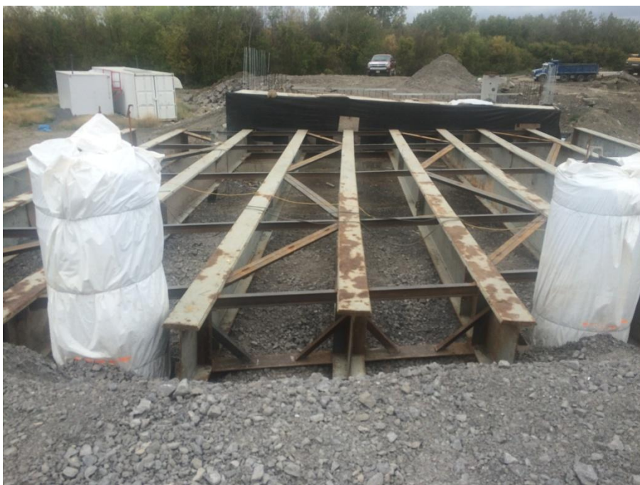
Poutres de soutien de la travée ouest de la structure de la promenade Riverside pour l'échafaudage du tablier
