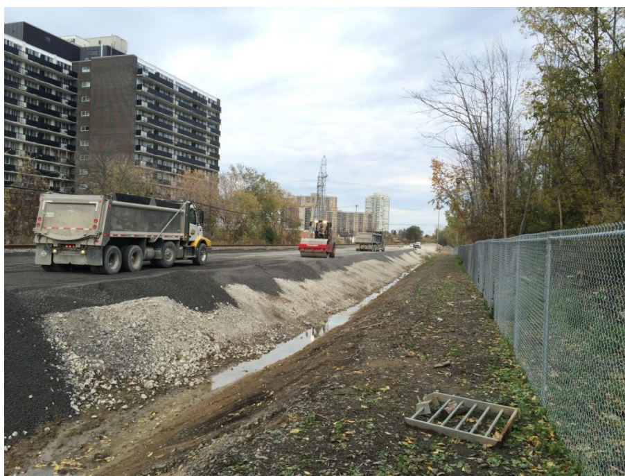
Mise en place du sous-ballast pour la nouvelle voie ferrée de VIA Rail
