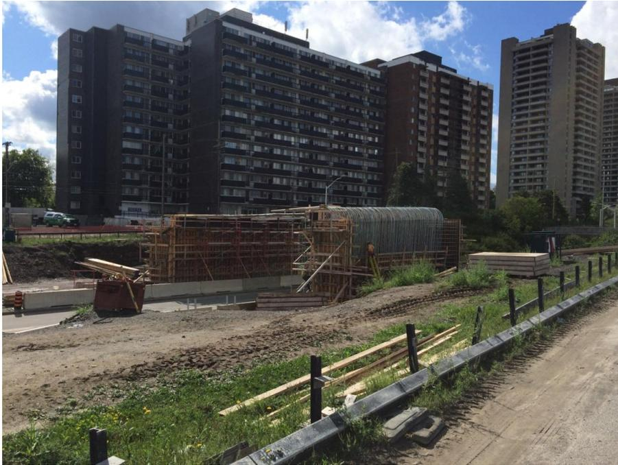
Construction des culées de la structure du Transitway.
