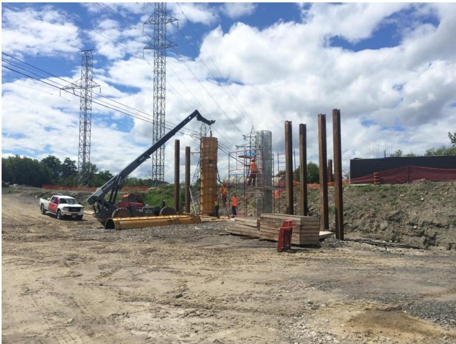
Construction des colonnes de piliers de la structure de la promenade Riverside.
