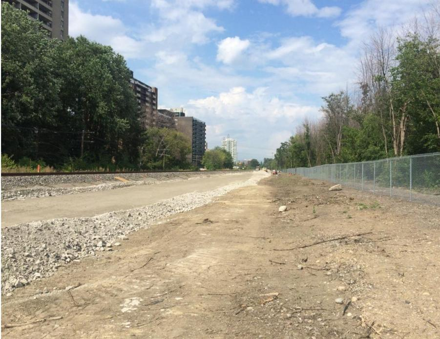
Construction du remblai de la voie de contournement de VIA Rail.
