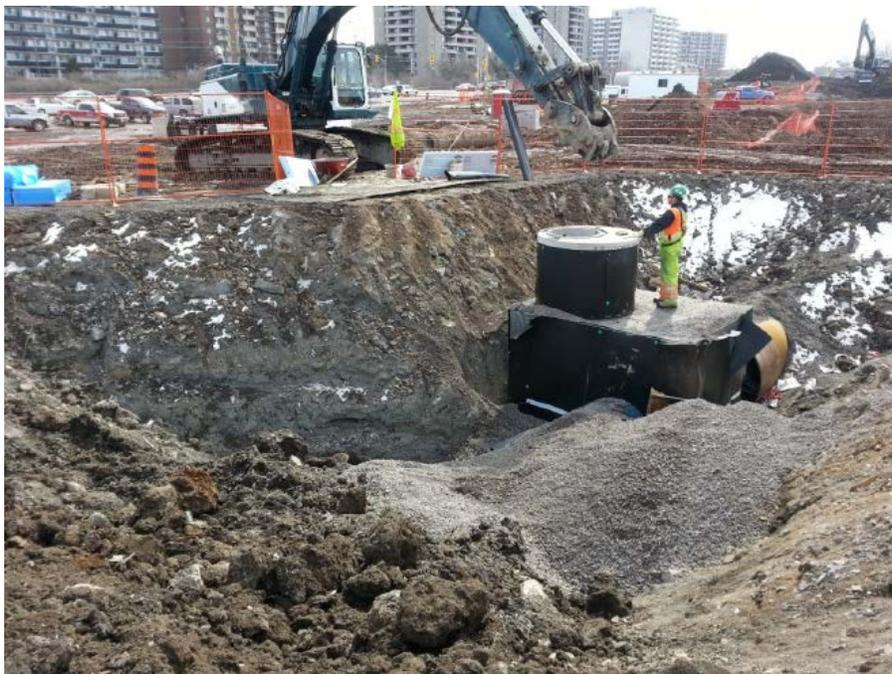
Chambre de soupapes de la canalisation principale de 914 mm
