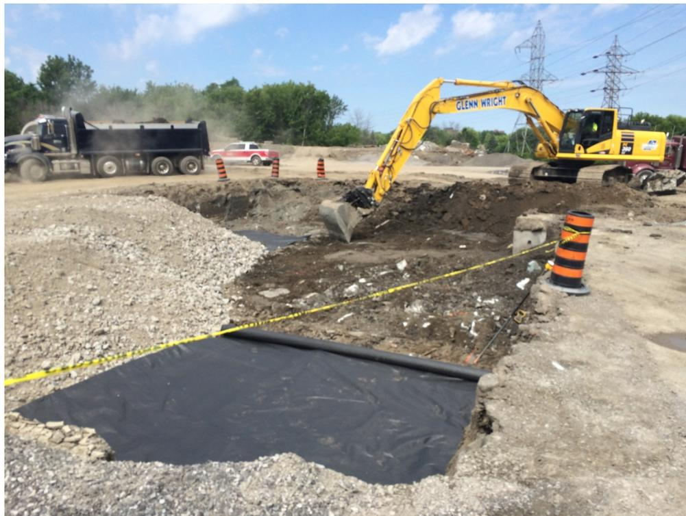
Excavation et mise en place de la toile de géotextile et des matériaux d'infrastructure pour le prolongement de la ruelle Frobisher.
