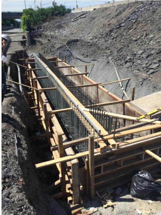
Mise en place des barres d'armature de la culée de la structure du Transitway, à l'ouest.
