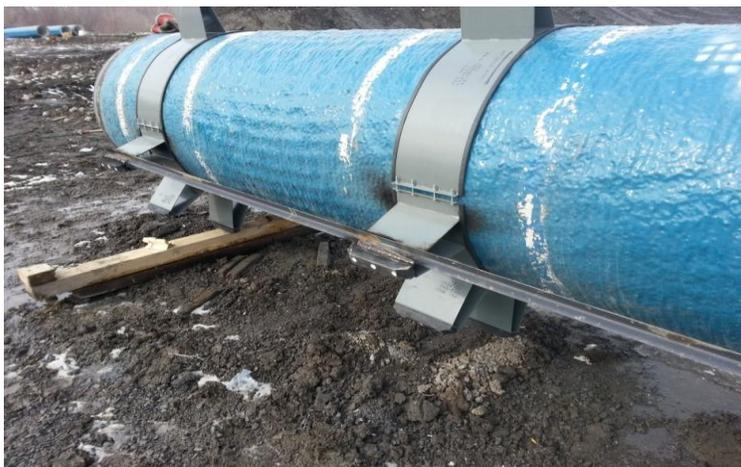
Conduite de 914 mm de diamètre pour installation à l'intérieur d'une coque de protection – 13 avril 2015
