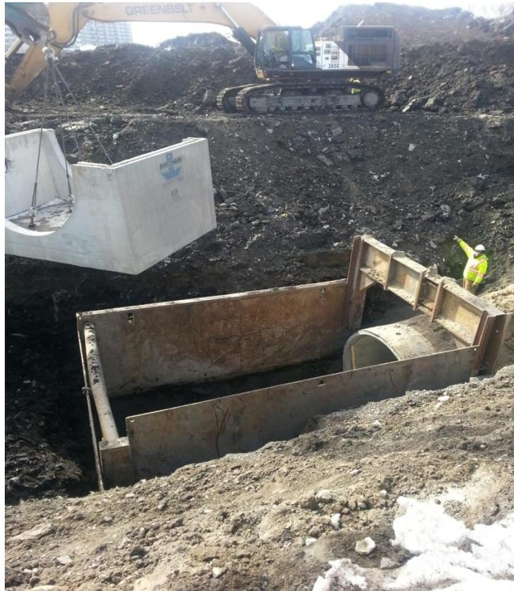
Installation d'un égout pluvial de grand diamètre – 8 avril 2015
