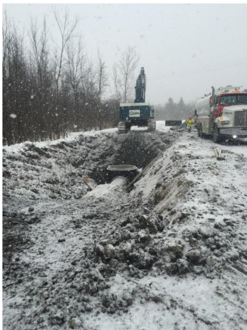
Installation des égouts pluviaux le long du tronçon vers l'hôpital, à l'est de la promenade Alta Vista.
