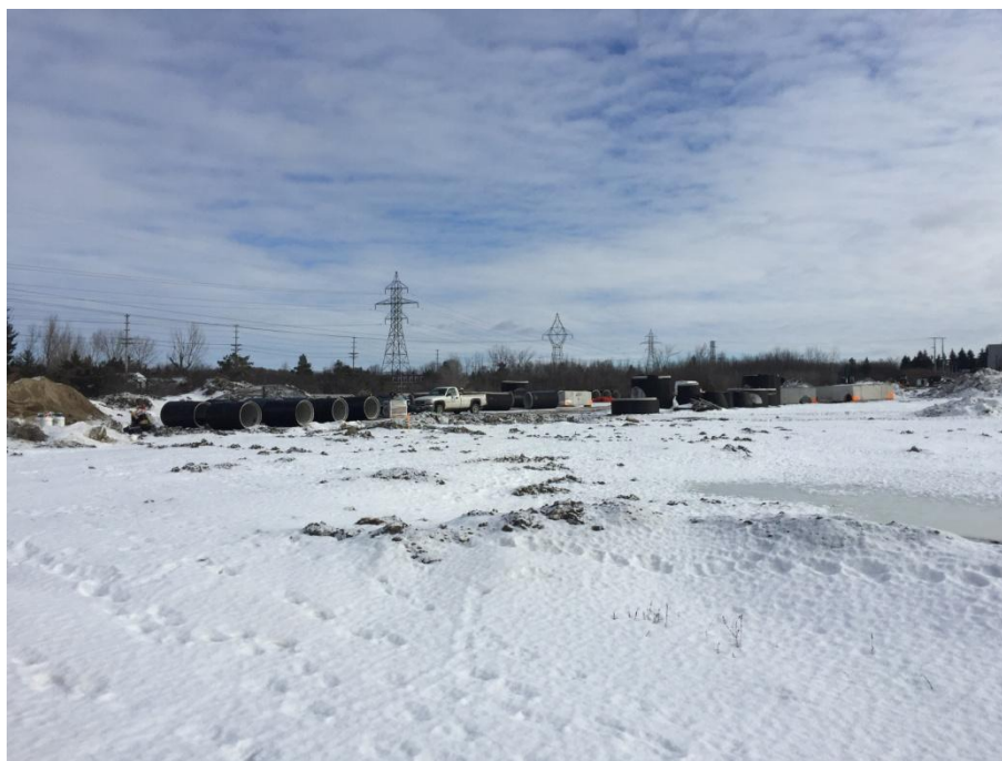
Application d'une couche protectrice sur les égouts pluviaux.
