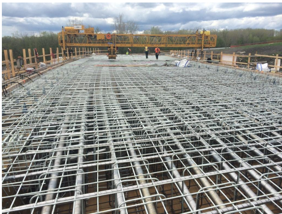
Barres d'armature et précontrainte par post-tension pour le tablier de la structure de la promenade Riverside.
