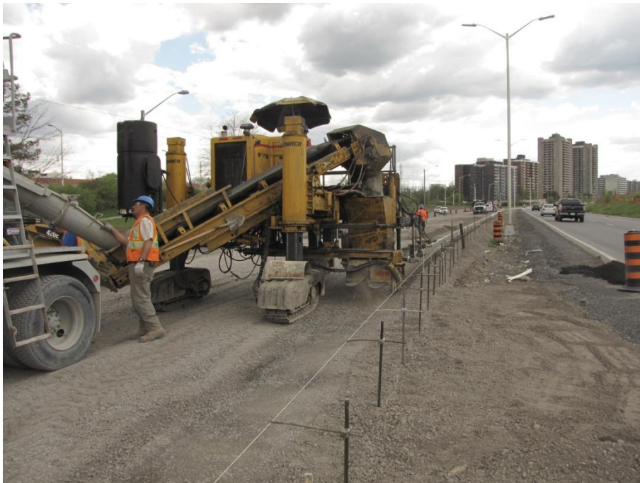
Installation de la bordure le long de la promenade Riverside en direction nord.
