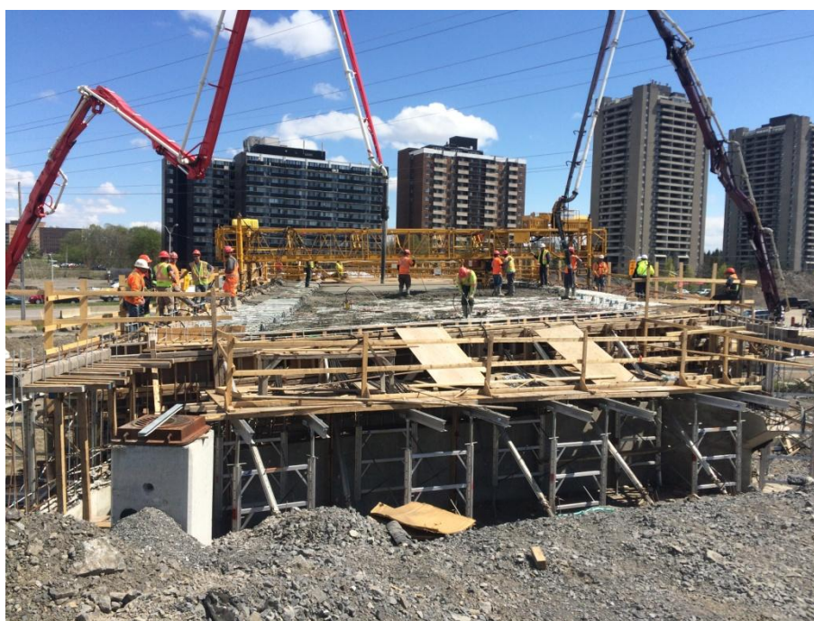
Coulage du tablier de la structure de la promenade Riverside.
