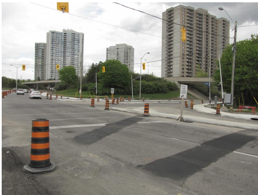
Nouveaux trottoirs, îlots et terre-pleins centraux en béton à l'intersection de Hincks et Riverside.
