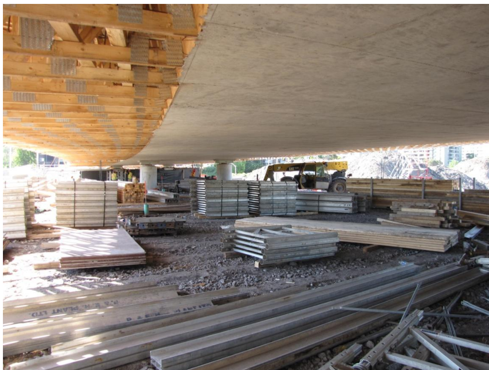
Enlèvement du coffrage et de l'échafaudage du tablier de la structure Riverside.
