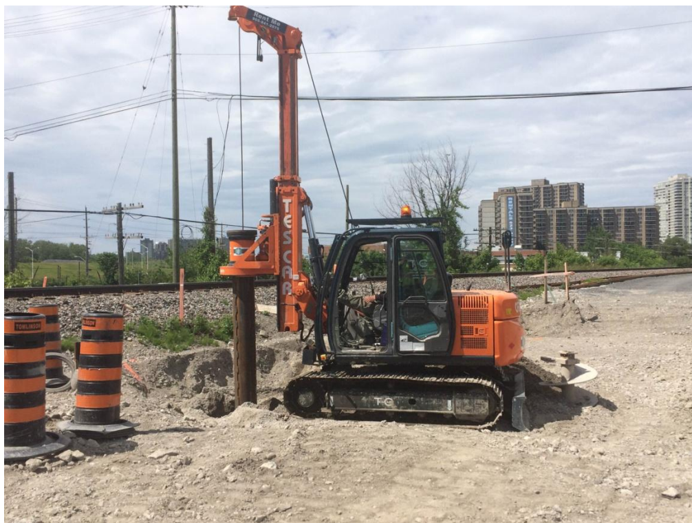
Forage du mur d'étalement de VIA
