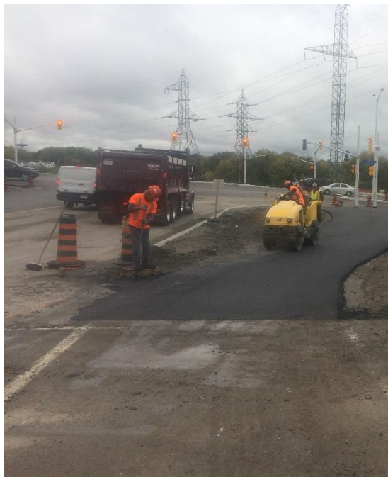
Pavage des nouveaux sentiers le long de la ruelle Frobisher et du nouveau tracé de la promenade Riverside.
