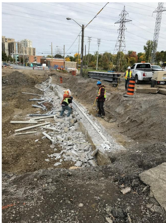
Retrait du massif de conduits existant le long de la promenade Old Riverside.
