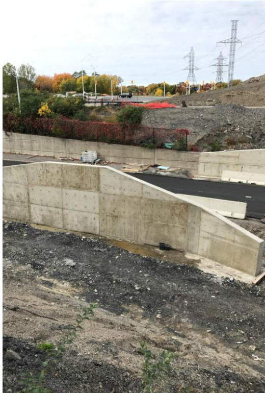
Nouveau mur de soutènement sud-est du Transitway.
