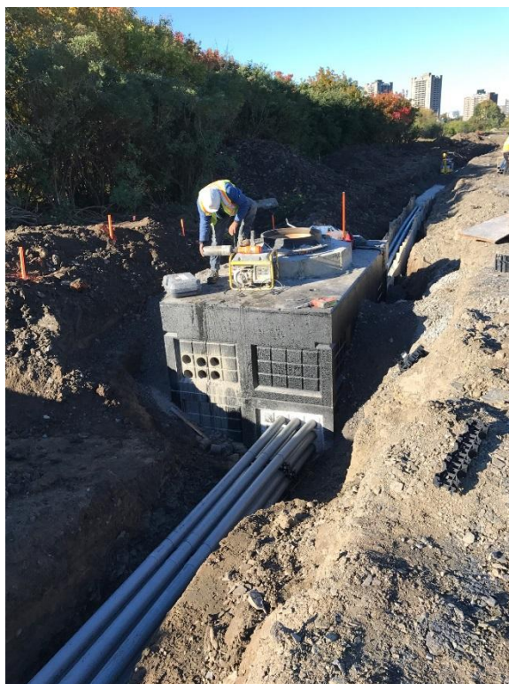
Installation du nouveau massif de conduits d'Hydro Ottawa le long du tronçon vers l'hôpital.
