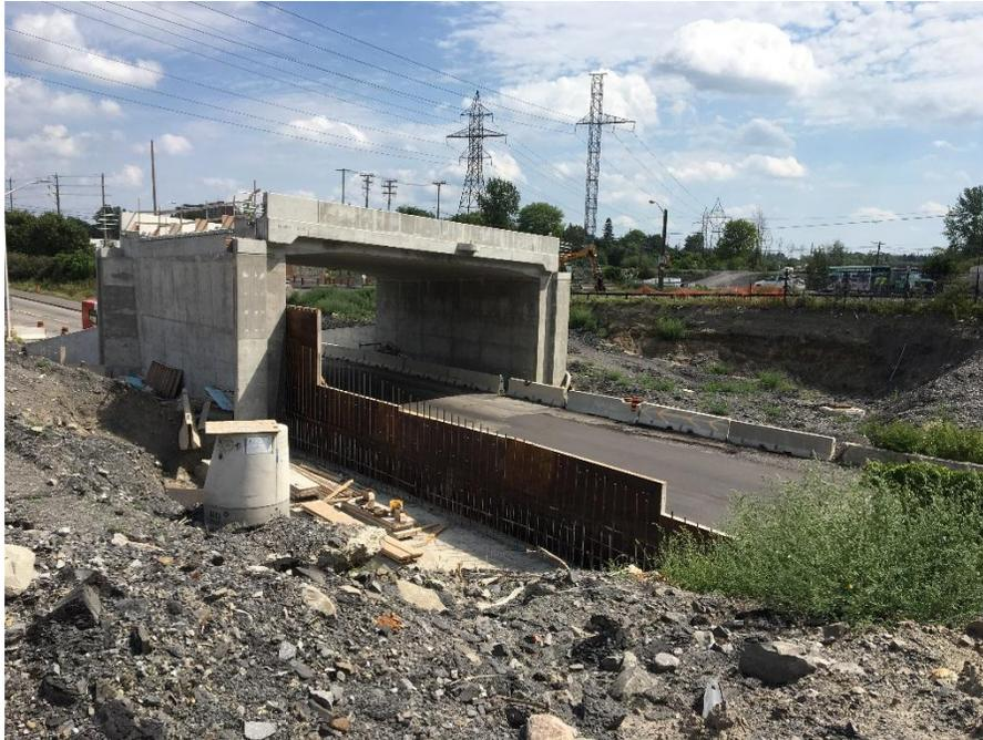
Construction du mur de soutènement sud-ouest du Transitway.
