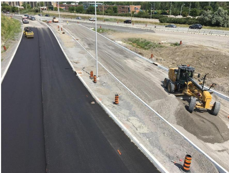
Asphaltage et nivelage de la promenade Riverside, au nord de la structure.
