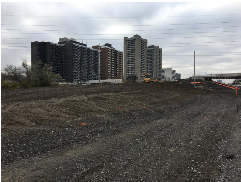
Nivellement et formation de bermes le long du nouveau tracé de la promenade Riverside du côté est (vue du nord de la structure Riverside)
