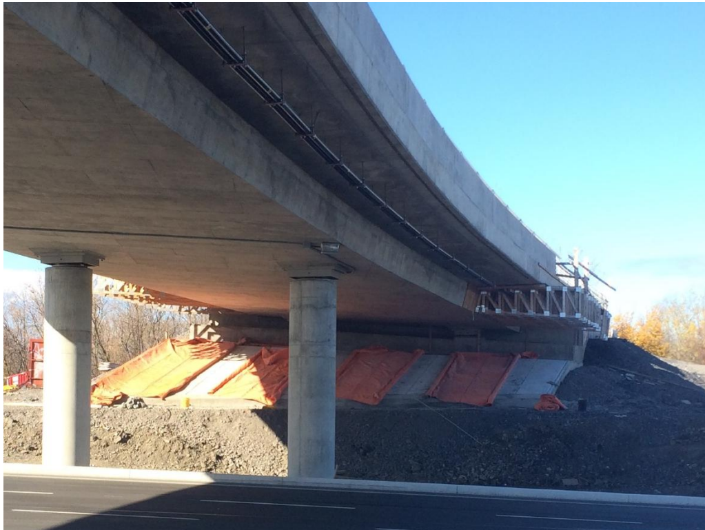
Coulée de béton et asphaltage des pentes de la structure Riverside (vue de l'ouest)
