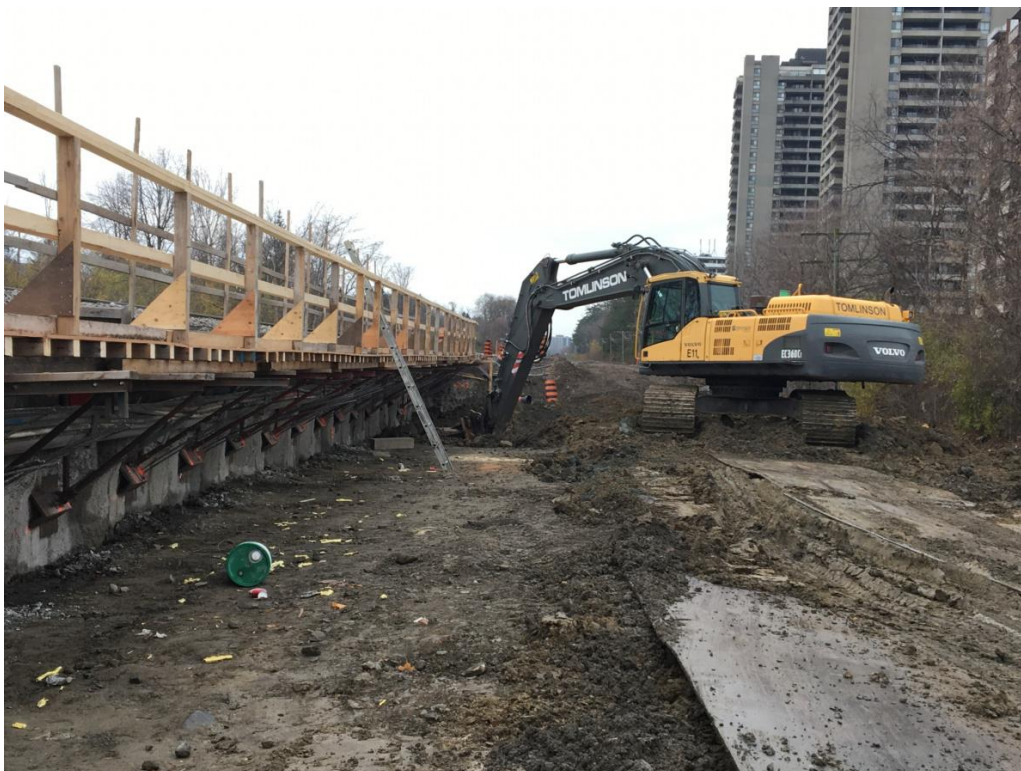
Excavation en vue de l'installation de la deuxième rangée de boulons d'ancrage sur le mur de soutènement dans le couloir de Via Rail.
