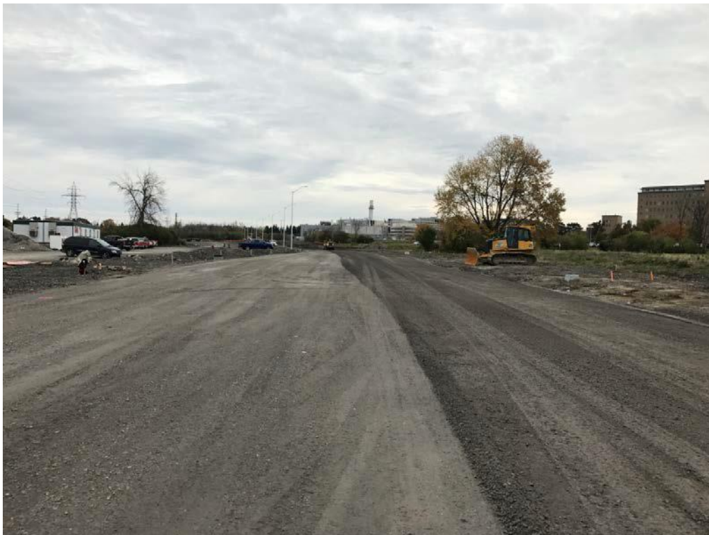
Nivellement de finition et compactage du matériau granulaire sur le tronçon vers l'hôpital à l'est de la promenade Alta Vista
