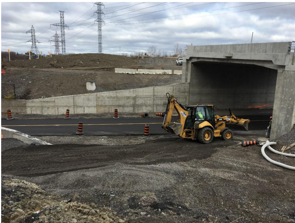
Nivellement de matériau granulaire de type B le long du Transitway, côté ouest.
