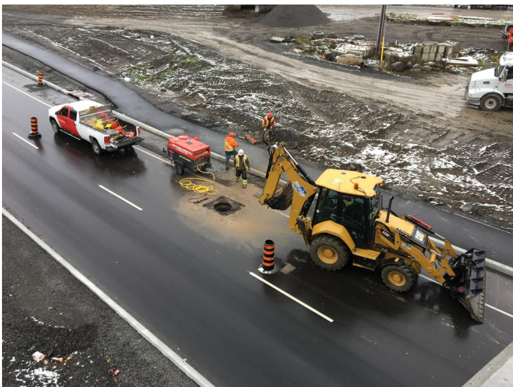
Ajustement des regards d'égout dans la voie vers le nord du nouveau tracé de la promenade Riverside
