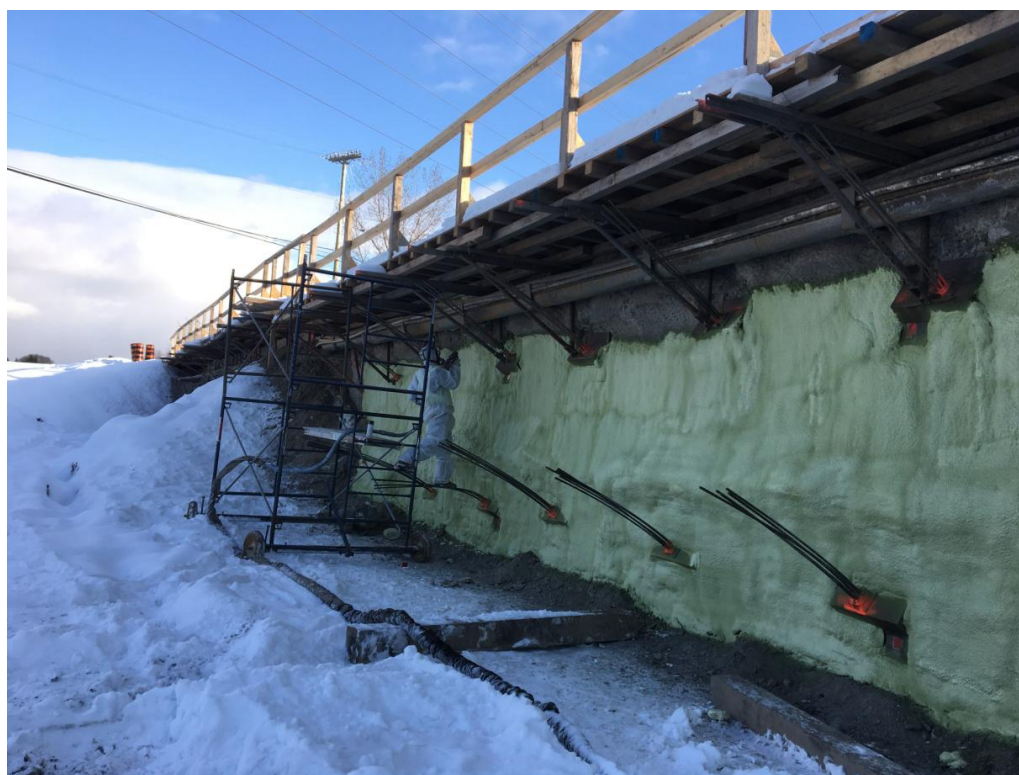
Employés de Premium Insulation sur place isolant le mur de soutènement situé dans l'emprise de VIA
