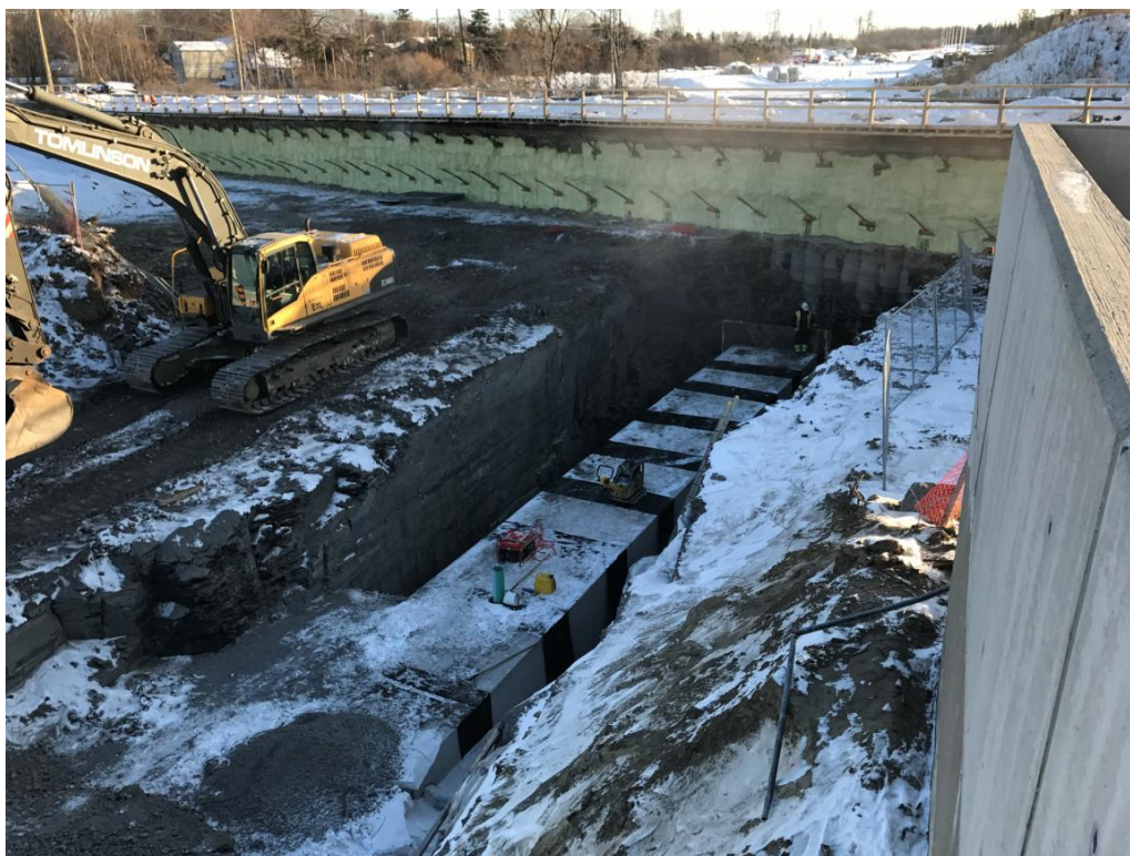
Installation de l'égout pluvial fermé de 1800 mm x 2400 mm entre le cul-de-sac sud et le mur de soutènement
