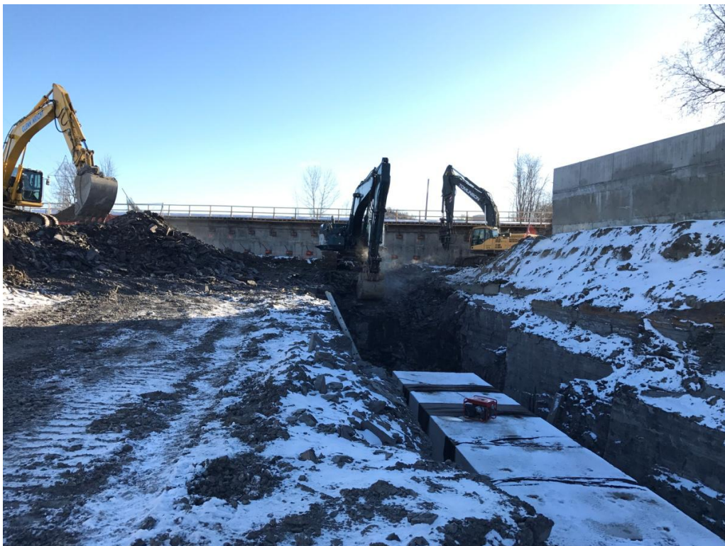
Installation de l'égout pluvial fermé de 1800 mm x 2400 mm entre le cul-de-sac sud et l'emprise de VIA
