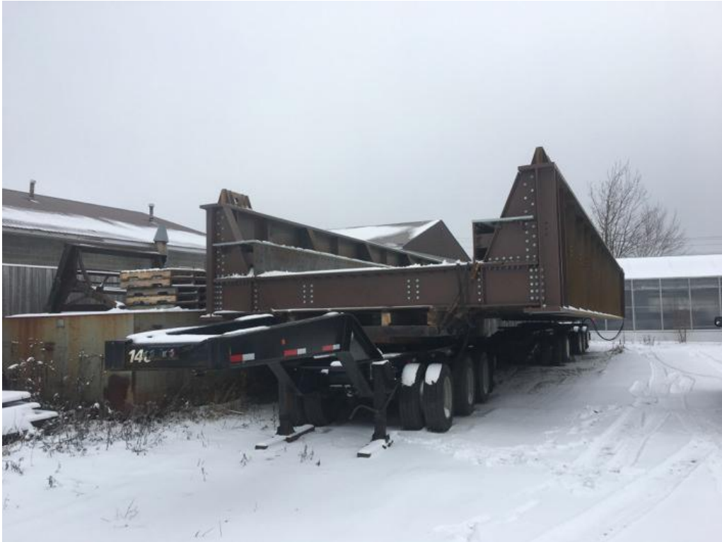
Segment n° 1 de la structure de VIA Rail, tiré du rapport d'inspection de soudure, le 6 décembre 2016
