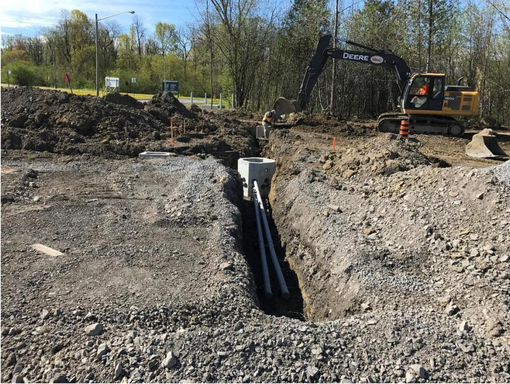
Installation de l'infrastructure souterraine pour les installations de régulation de la circulation et l'éclairage de rue à l'ouest de la promenade Alta Vista pour la future intersection avec le tronçon vers l'hôpital.
