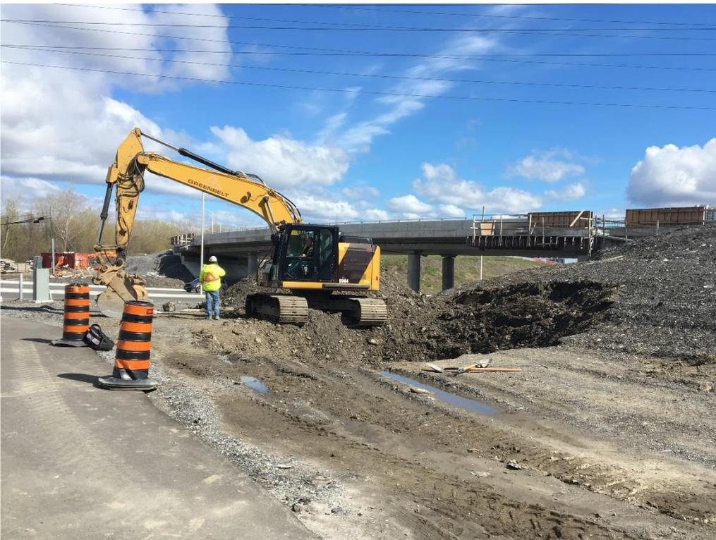
Excavation pour réparer la canalisation principale à l'intersection de la ruelle Frobisher et de la promenade Riverside.
