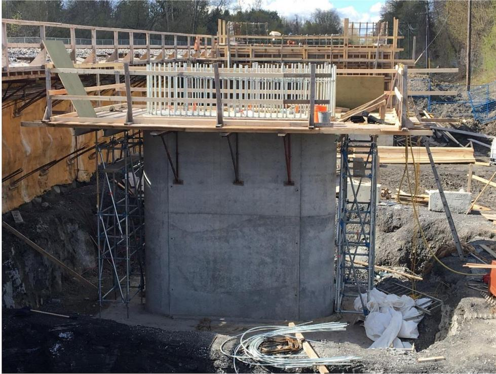
Construction du pilier sud et du couronnement à la structure de VIA.
