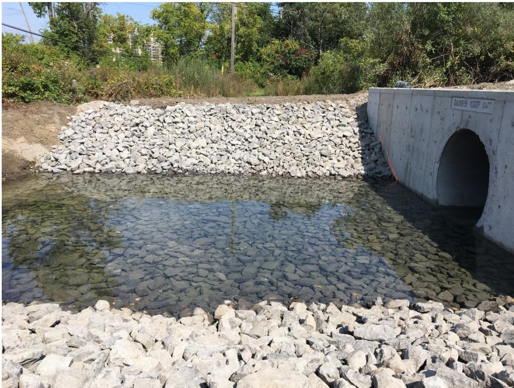
Construction du ponceau du tronçon vers l'hôpital avec mur de tête en béton et enrochement protecteur
