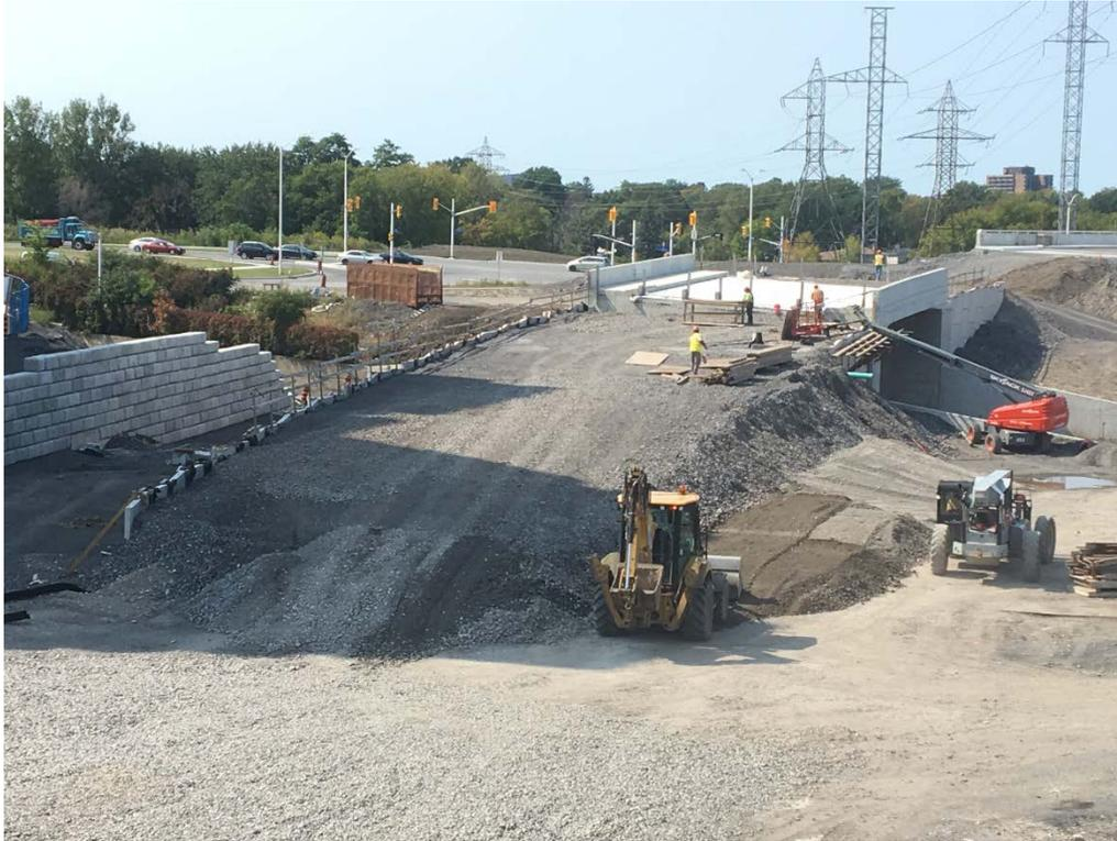
Nivellement et murs de soutènement du côté est de la structure du Transitway
