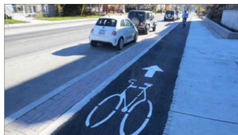
Alternative 3: Transit lane (not shown) and raised cycle track / Option 3: Voie pour le transport en commun (non indiquée) et voie cyclable surélevée
